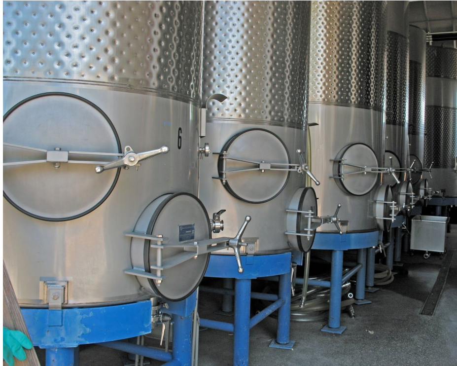
Zbiorniki fermentacyjne ze stali nierdzewnej
